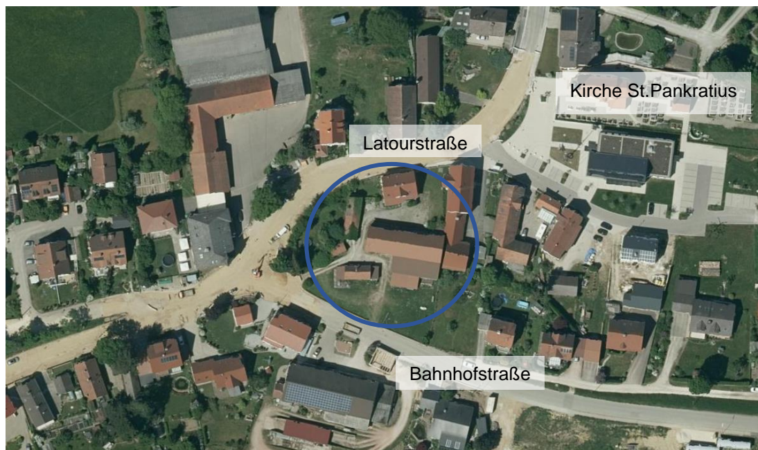
Abb. 1: Luftbild mit Kennzeichnung des Plangebiets, o.M. 1
